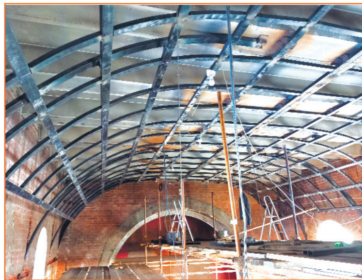
Монтаж металлической конструкции арочного свода
